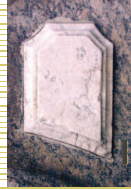
TRECHO ANALISADO FACE A
