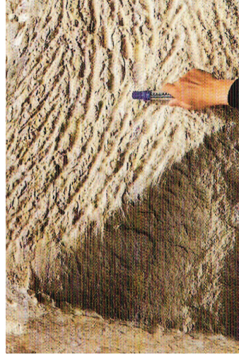
IMAGEM III.13: Marca de utensílios para o desmonte de pedra (pedreira antiga de Reguengo do Fetal - Batalha/ Portugal. Fonte: AYRES-BARROS, 2001
