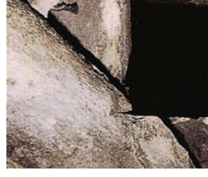
FIGURA III. 31: Vista aproximada de corte em área pré-existente, para inserção de novo elemento. Fonte: AIRES-BARROS, 2001b.
