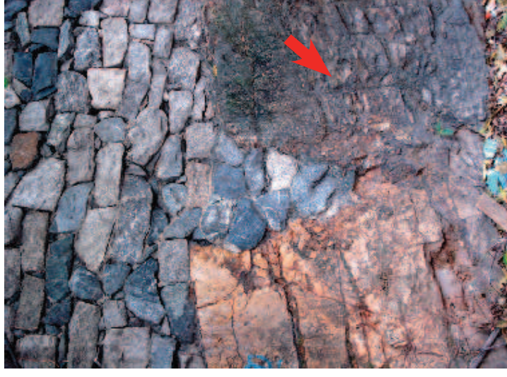
IMAGEM 1.21: Detalhe do embasamento do arrimo da Ladeira da Misericórdia (RJ). Foto da autora (março/2008).
