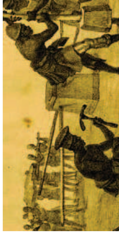
IMAGEM III. 20d: a ferramenta em segundo plano, a julgar pelas longas alças, provavel- mente destina-se ao nivelamento entre os blocos de pedra
