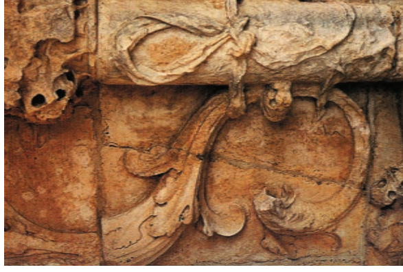
IMAGEM III. 26: Detalhe de juntas. Fonte: AIRES-BARROS, 2001b.
