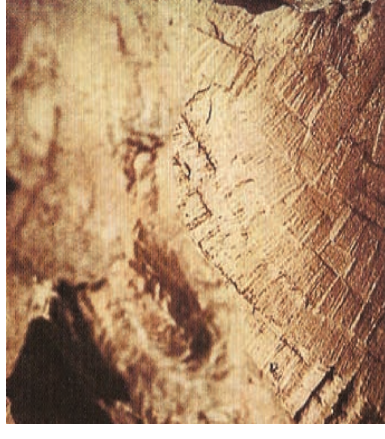
FIGURA III. 30: Textura aplicada pelo escopro. Fonte: AIRES-BARROS, 2001b.
